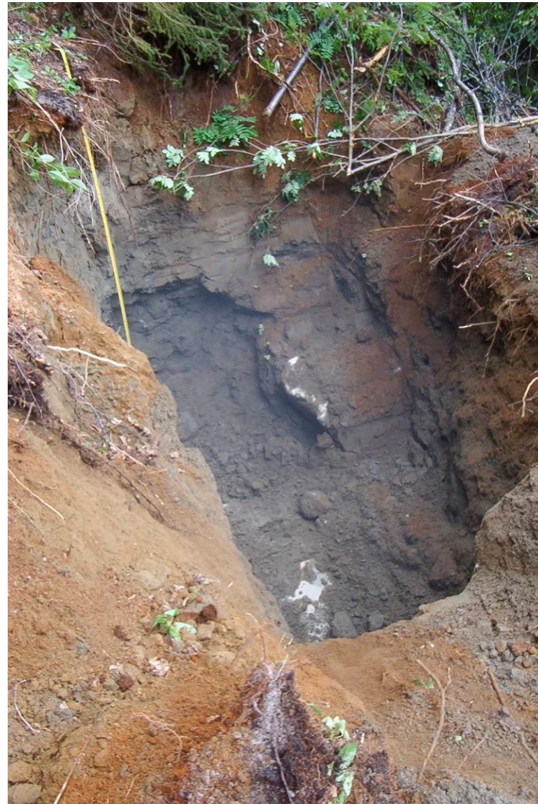
Photo 3.16 Chaînage 2199+650, au droit de la ligne de centre (vue vers le nord)
