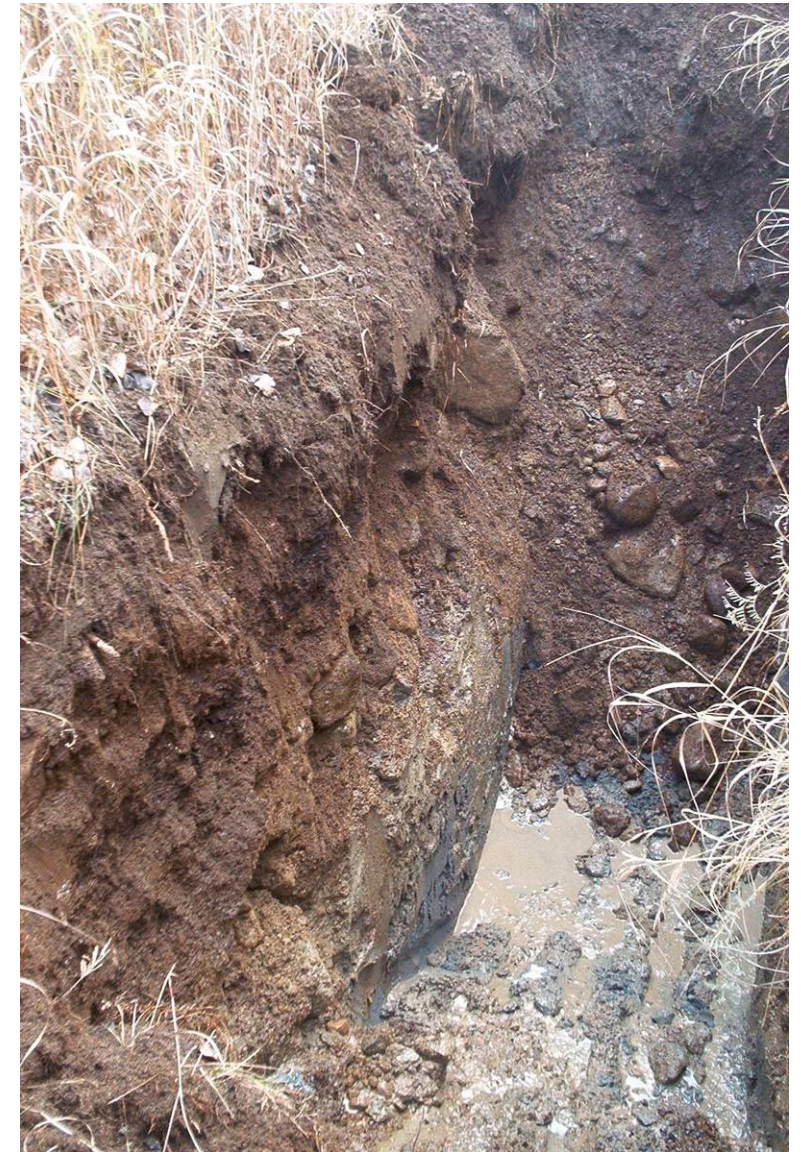
Photo 3.8 Chaînage 2198+050, 12 m à gauche de la ligne de centre
