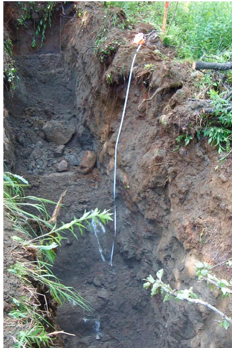
Photo 3.13 Chaînage 2199+300, au droit de la ligne de centre (vue vers le sud)
