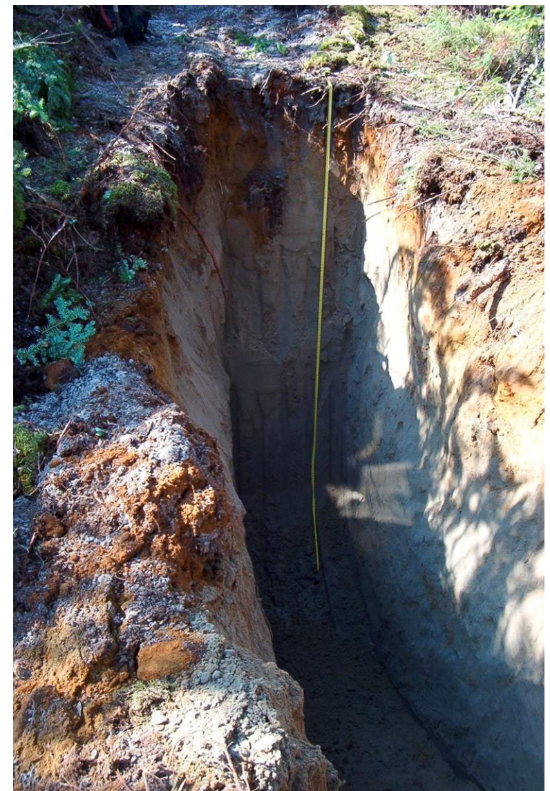
Photo 3.35 Chaînage 2203+450, au droit de la ligne de centre (vue vers le sud)
