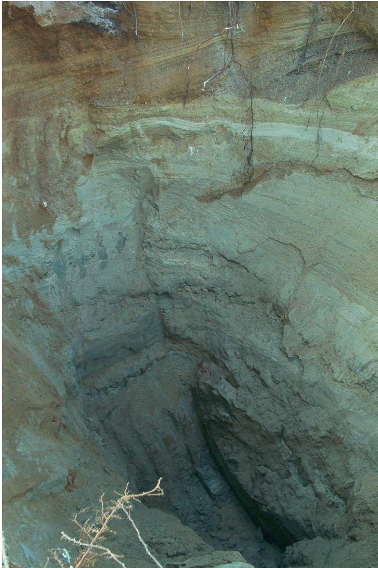
Photo 3.6b Chaînage 1197+980, 16 m au droit de la ligne de centre
