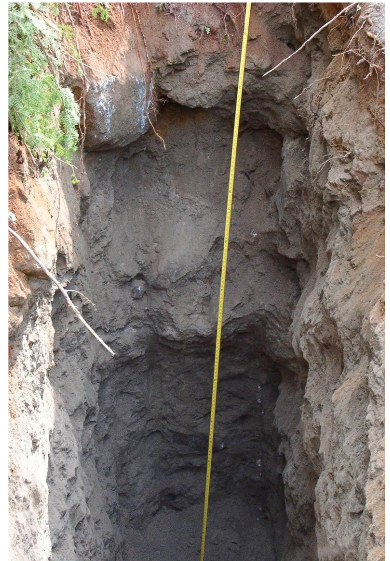
Photo 3.46 Chaînage 2206+350, au droit de la ligne de centre (vue vers le sud)
