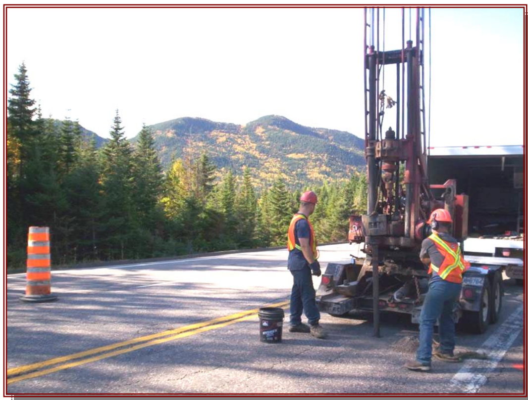
Figure 3 – Forage dans la chaussée existante à l'aide de la foreuse Diedrich D 50
