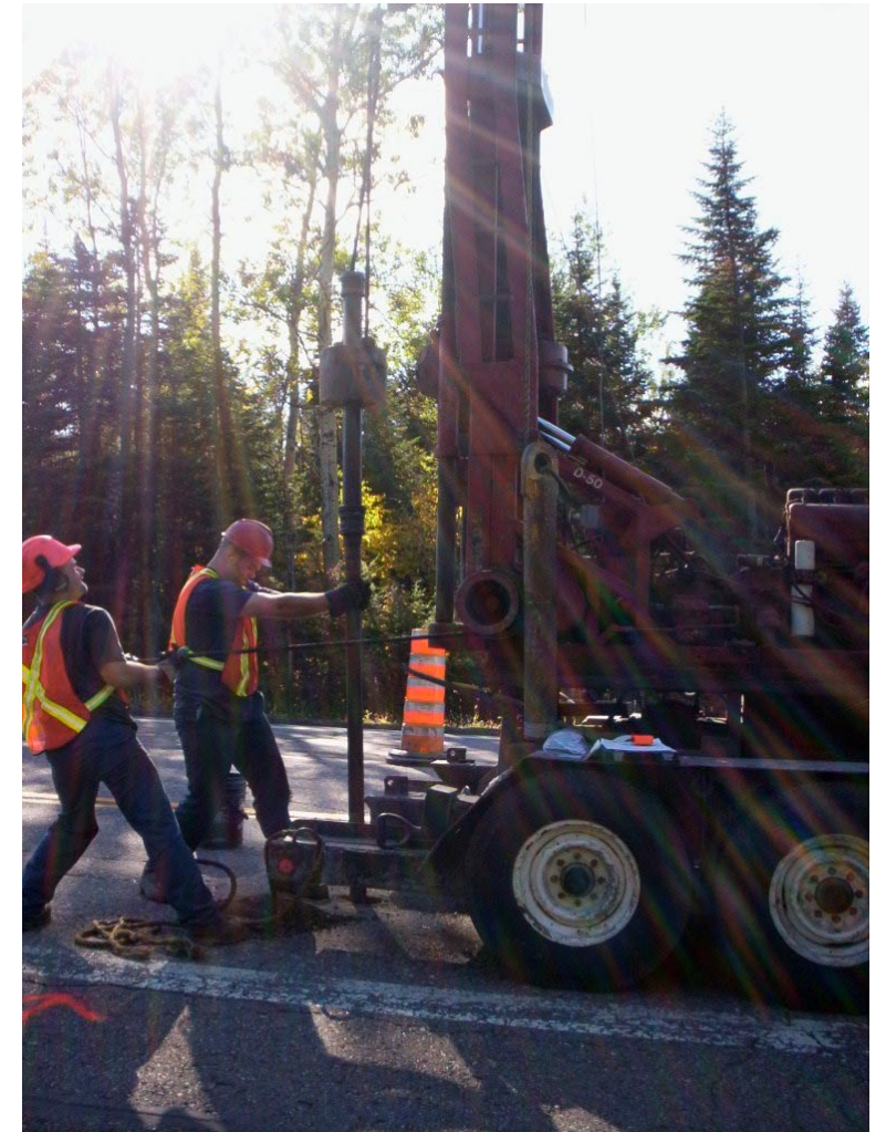
Photo 3.55 Forage dans la chaussée
