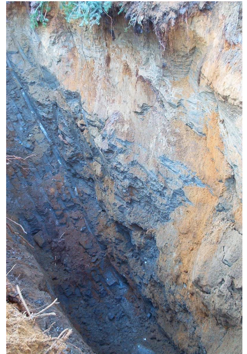
Photo 3.29 Chaînage 2202+400, 13 m à gauche de la ligne de centre
