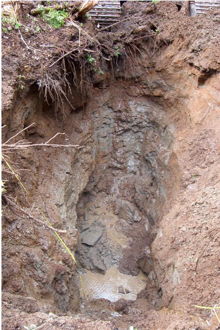
Photo 3.30 Chaînage 2202+450, au droit de la ligne de centre (vue vers l'ouest)
