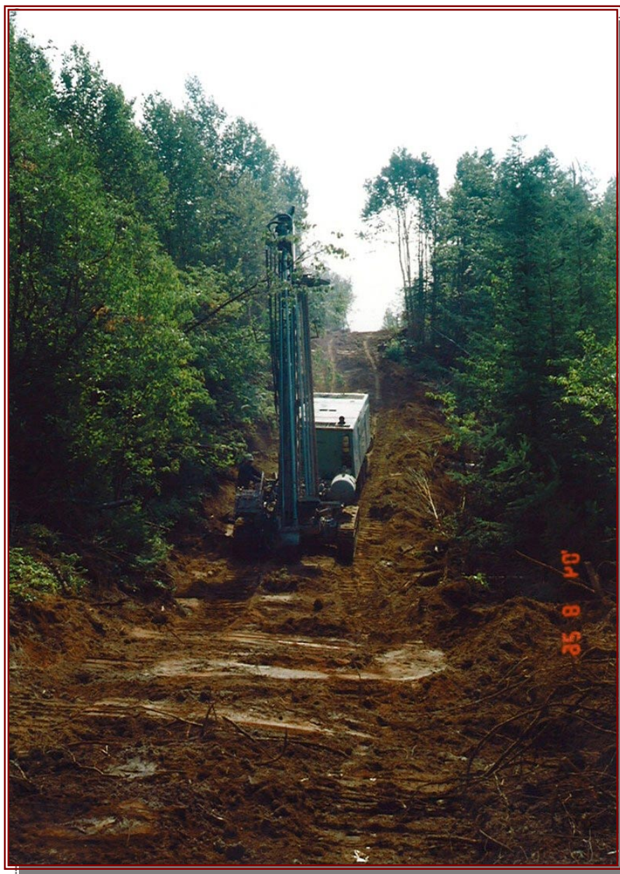
Figure 4- Foreuse à air comprimé utilisée pour les forages à percussion dans les secteurs à déblais importants
