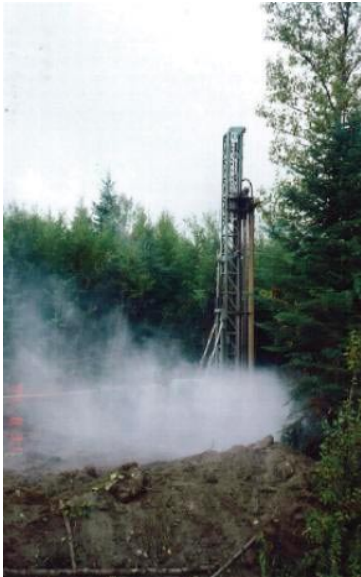
Photo 3.53 Foreuse à l'air (Air Track) en opération
