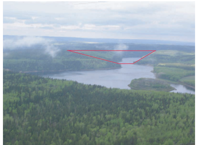
Crête du barrage projeté d'Ashuapmushuan 3 (AS-3). Haut de 104 m et long de 340 m.
