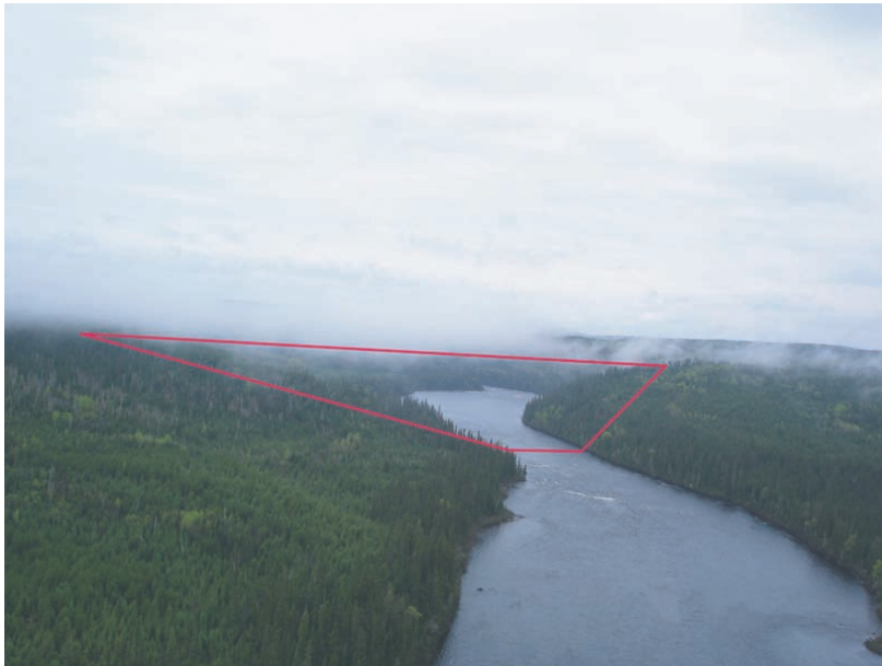
Crête du barrage projeté d'Ashuapmushuan 4 (AS-4). Haut de 88 m et long de 800 m.
