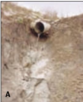
Figure 16 : Concentration d'eau (A : ravinement, B : érosion verticale)
