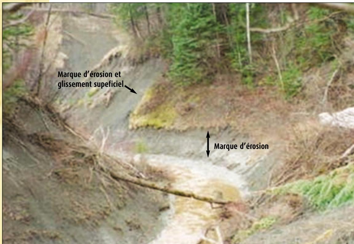
Figure 10 : Marques d'érosion et de glissement superficiel
