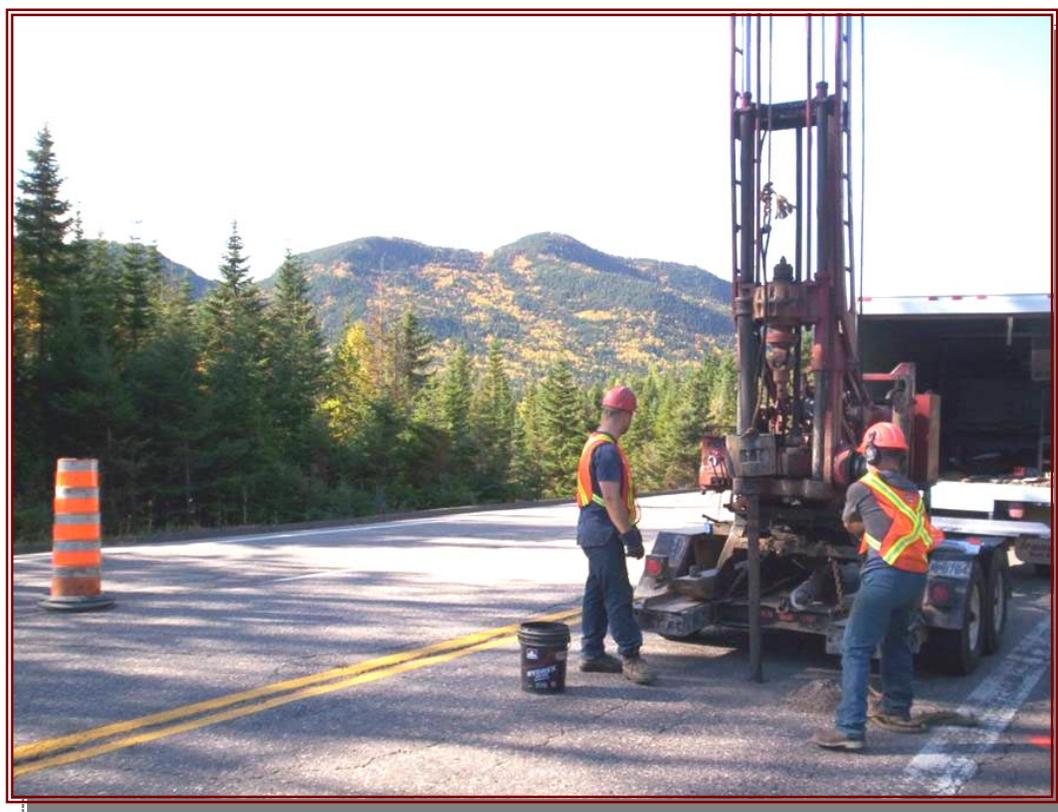
*Figure 3 – Forage dans la chaussée existante à l'aide de la foreuse Diedrich D 50*
